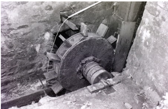
Roue hydraulique et marteau d'un martinet de Durfort
